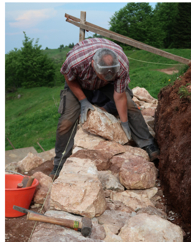
Fig. 1 - La posa di un concio durante un corso di costruzione di muri di contenimento in pietra a secco
