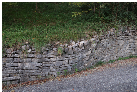
Fig. 15 - Muro deformato in seguito a un cedimento del terreno nelle vicinanze dopo gli scavi per la costruzione di una villa. Il muro ben costruito si deforma essendo costituito da diversi elementi, ma si adatta alla nuova configurazione senza crollare.
