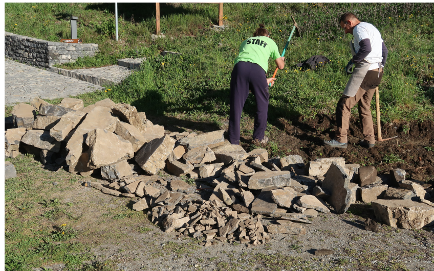
Fig. 4 – Pietre divise per dimensione prima di iniziare i lavori
