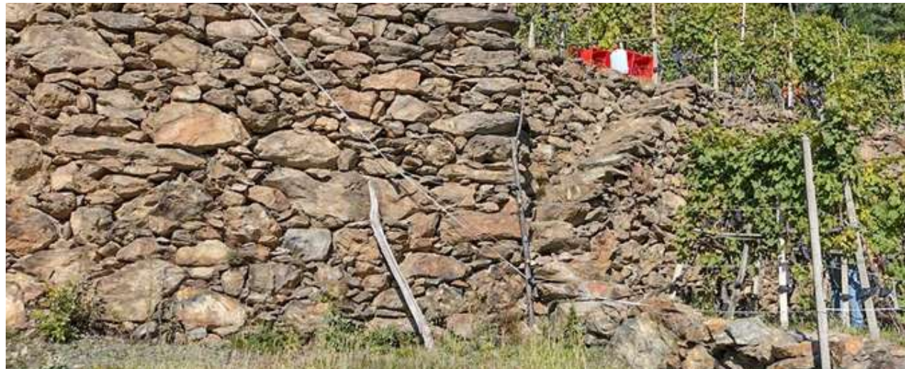
Figura 1 - Terrazzamenti costruiti pressoché esclusivamente in elementi di micascisti del Basamento Sudalpino, visibilmente alterati, affioranti sul posto – a monte di Triasso (Sondrio). (immagine: Alfredo Dell'Agosto)
