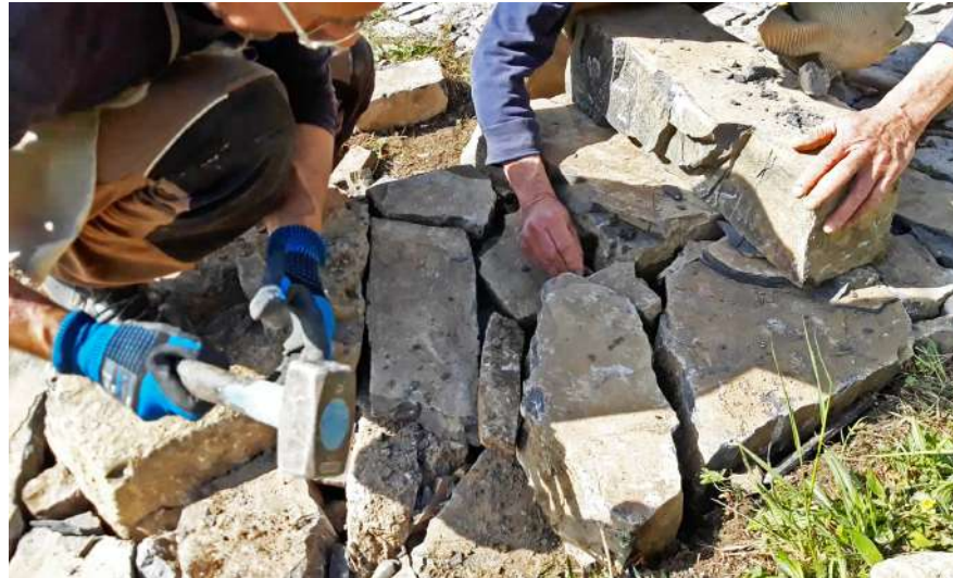
Fig. 33 - Riempimento degli interstizi con pietre della dimensione adeguata, procedendo a scalare proporzionalmente dalle pietre grandi alle medie, e dalle medie alle piccole.
