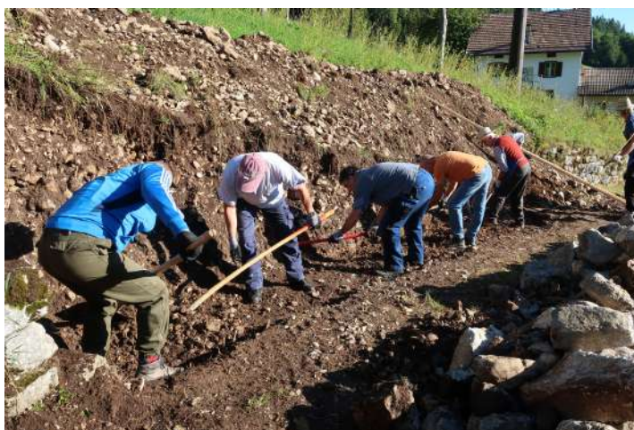
Fig. 18 - Preparazione dello scavo manuale durante un corso
