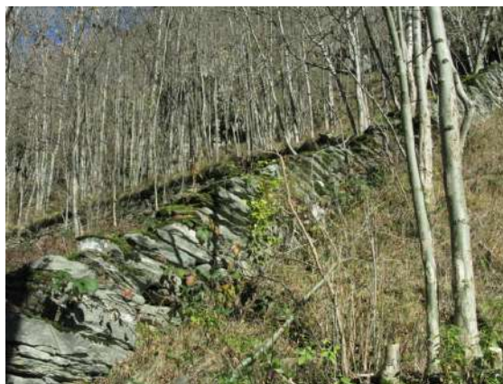
Figura 14 - manufatto di confine di proprietà formato in prevalenza da elementi tabulari di gneiss (beola) sovrapposti orizzontalmente lungo la linea di massima pendenza del terreno, Valmalenco, comune di Torre di S. Maria. (immagine: Alfredo Dell'Agosto)
