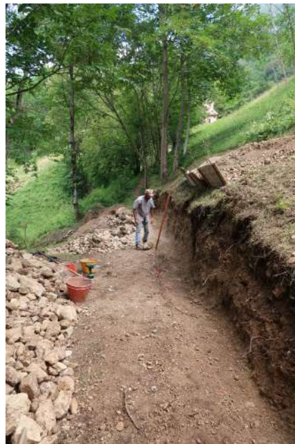
Fig. 16 - 17 - Area di cantiere organizzata e scavo pronto per l'esecuzione del muro di contenimento con due visuali A e B.
