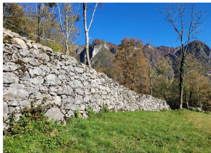
Fig. 3 - Muro di contenimento a regola d'arte Val Brembana
