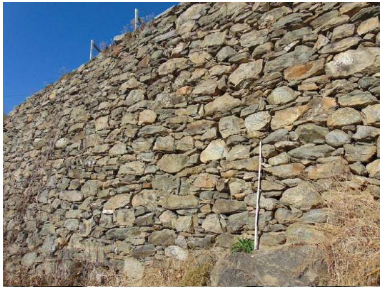
Figura 8 - Pregevole manufatto con altezza max superiore ai 3 m; realizzato prevalentemente con scisti del Sudalpino affioranti sul posto, presenta anche riconoscibili elementi alloctoni, in particolare granitoidi e metagranitoidi. Zona Grumello – Montagna in Valtellina (immagine: Alfredo Dell'Agosto)
