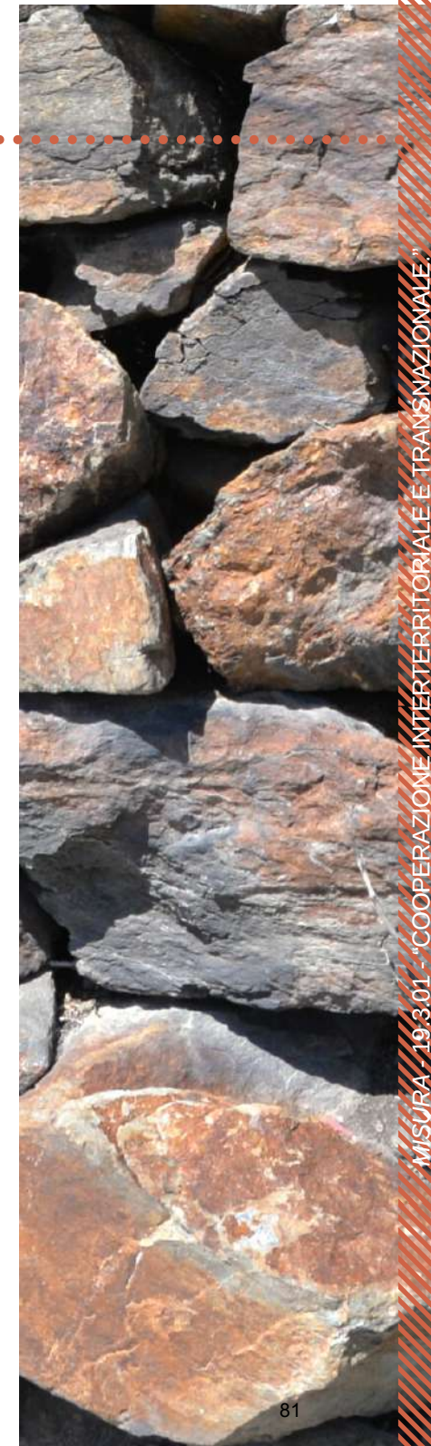
Fig. 39 – Si noti che nel contromuro (paramento interno), vi sono molti giunti sovrapposti poiché non si è posta abbastanza cura e controllo della costruzione del retro.
