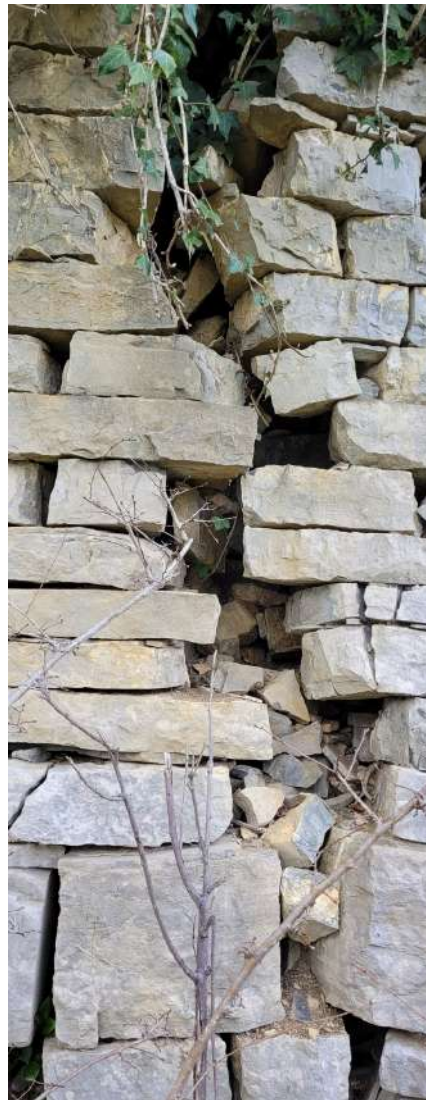
Fig. 21 - Crollo muro e scollegamento verticale Corna
