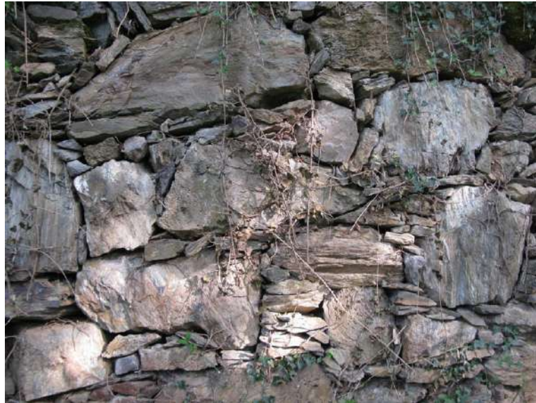
Figura 4 - manufatto realizzato quasi esclusivamente con elementi di "pietra verde di Tresivio" (siltite dolomitica del Servino), affiorante in vicinanza - Sentiero del Rat, Poggiridenti. (immagine: Alfredo Dell'Agosto)
