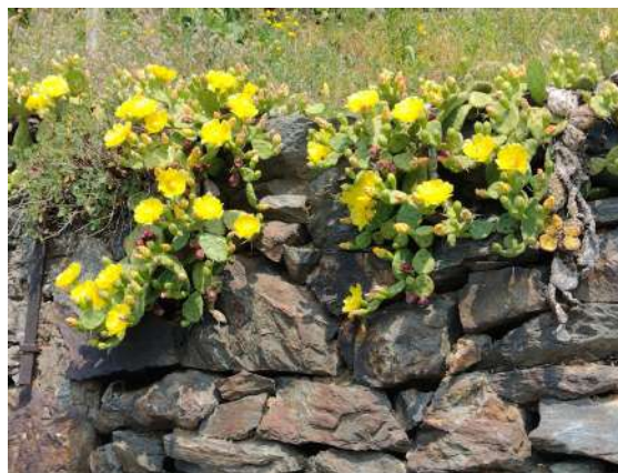
Figura 15 - manufatto dei terrazzamenti vitati, formato essenzialmente da elementi piuttosto irregolari di scisti del Basamento Sudalpino, ossidati, con una vistosa fioritura di opunzie autoctone, loc. Moroni, Castione Andevenno. (immagine: Alfredo Dell'Agosto)
