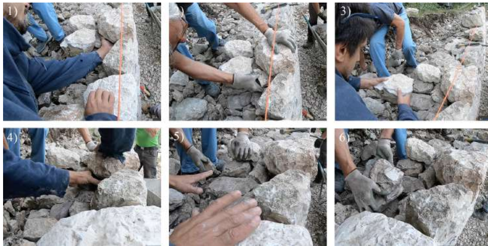
Fig. 43 - Sequenza di inserimento di un ricalzo: 1) la mano inserita sotto alla pietra ci aiuta a capire quando grande debba essere il ricalzo 2) prova di un ricalzo troppo grande 3) sostituzione di una pietra adiacente che ostacola l'inserimento del ricalzo 4) inserimento di ricalzo che entra al di sotto della pietra da stabilizzare 5) la pietra è stabile 6) si procede con il posizionamento di una pietra all'interno del muro
