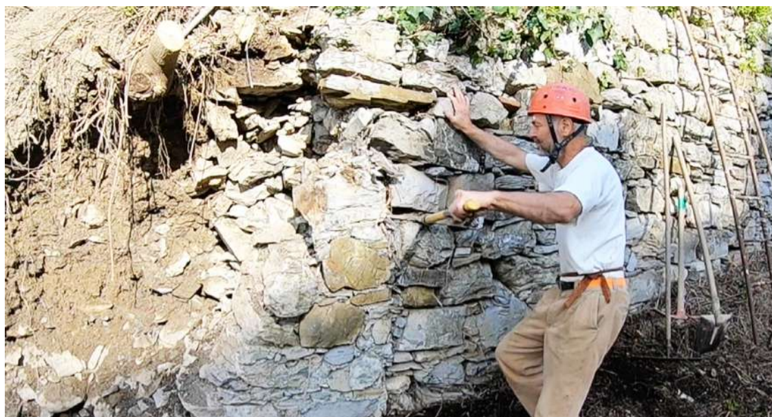
Fig. 15 – Smantellamento di un muro danneggiato da ricostruire
