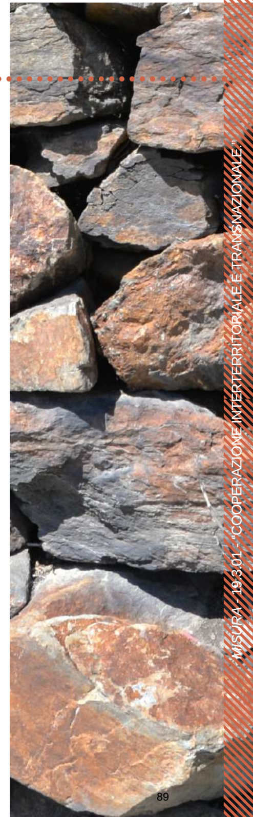
Fig. 48 A e B - Due esempi di drenaggio. Esempio A costituito da scagli di lavorazione e pietre molto piccole gettate sul retro per essere compattate. Esempio B costituito da pietre medio piccole poggiate a strati.
