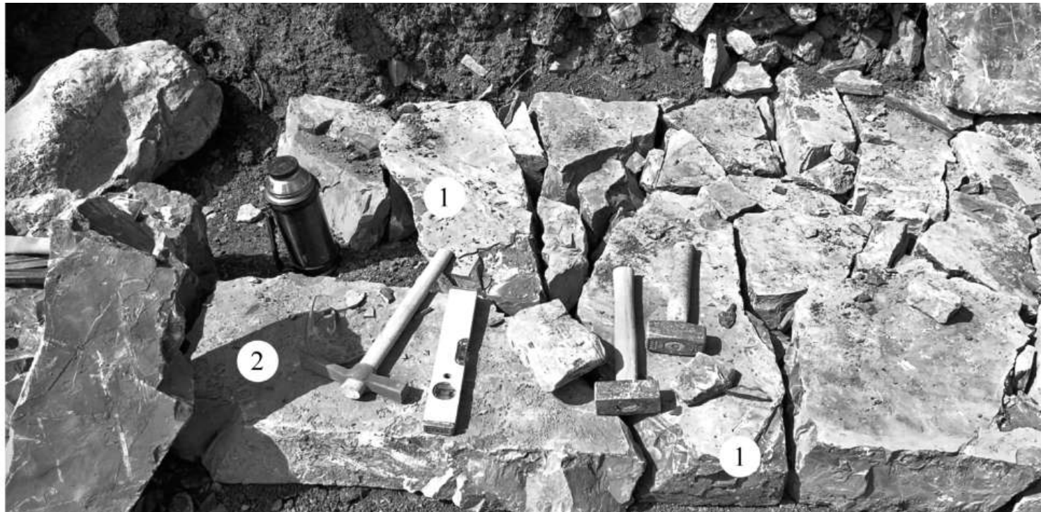
Fig. 6 – Parte esemplificativa di muro, in evidenza due semidiatoni (numero 1) e una pietra posata nelle fondazioni a corrente o pietra di fascia (numero 2).
