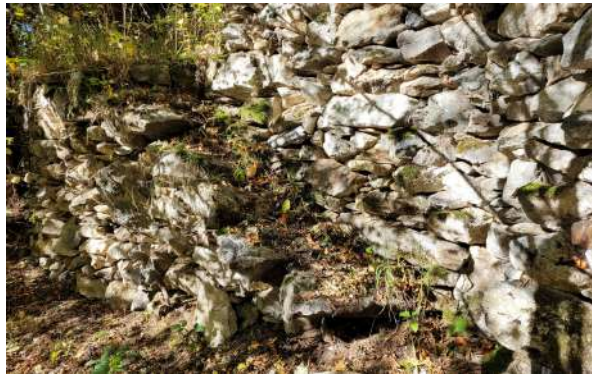
Fig. 25 - Scale e rampe Val Brembana
