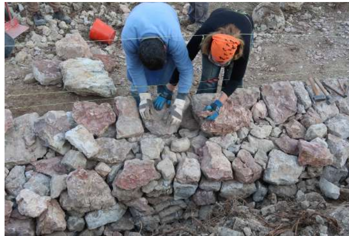
Fig. 39 – Si noti che nel contromuro (paramento interno), vi sono molti giunti sovrapposti poiché non si è posta abbastanza cura e controllo della costruzione del retro.
