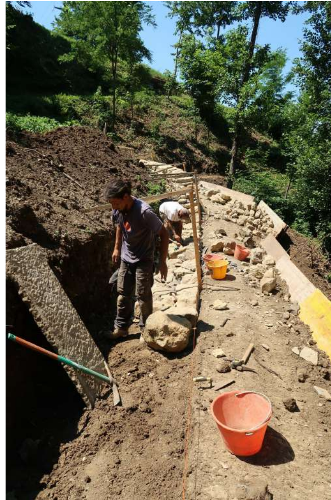
Fig. 27 A e B - Utilizzo dei montanti guida per costruire il profilo del muro a scarpa. Il caso A rappresenta la ricostruzione in continuità con un muro esistente che si usa come riferimento per l'inclinazione della scarpa. Il caso B è la costruzione di un nuovo muro con una scarpa progettata per il caso specifico.
