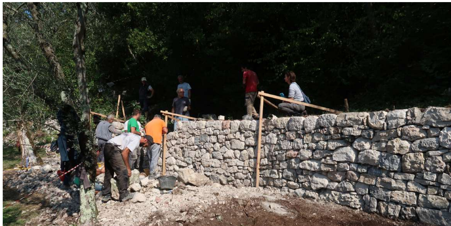
Fig. 49 - Al termine della costruzione del muro si procede con la pulizia del sito, come visibile in questo caso da destra verso sinistra, il camminamento viene sgomberato dai detriti e le pietre rimaste.
