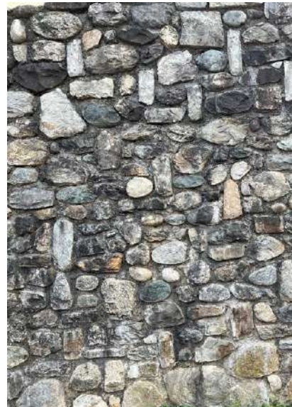
Figure 9 e 10 - Muro a secco in pietre molto arrotondate: altezza limitata e "qualità" geometrica del muro scarsa (fraz Gambirago di Cisano Bergamasco (BG). Nella seconda immagine, muro alto (>3 m) con pietre arrotondate con malta di cemento per garantirne la buona stabilità (Cimitero di Celana di caprino Bergamasco (BG). Foto Fabio Baio 2022
