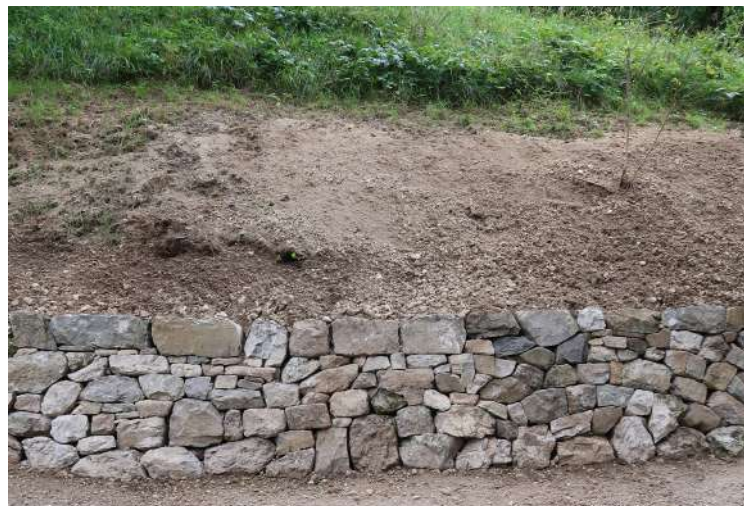
Fig. 45 - Esempio di coronamento con grandi pietre.
