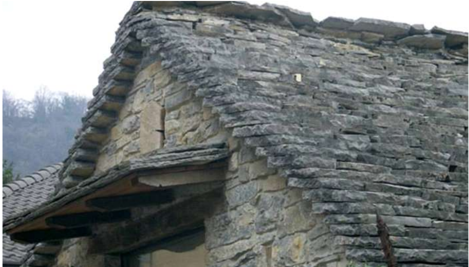
Figura 8 - Tipico tetto in "piöda" della Valle Taleggio e della Valle Imagna (da sito Web Camera di Commercio Industria di Bergamo - https://www.bg.camcom.it/pietre-originali-della-bergamasca/pietre/pietra-di-berbenno )
