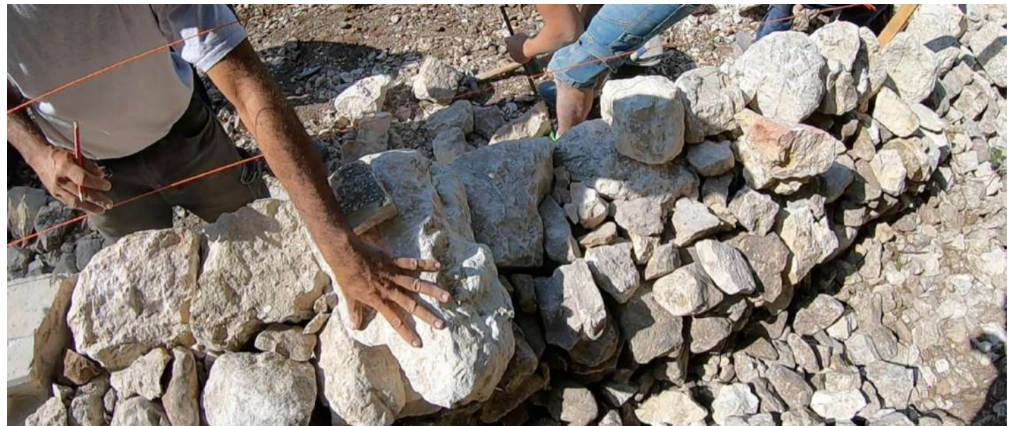
Fig. 30 - Posa di un diatono
