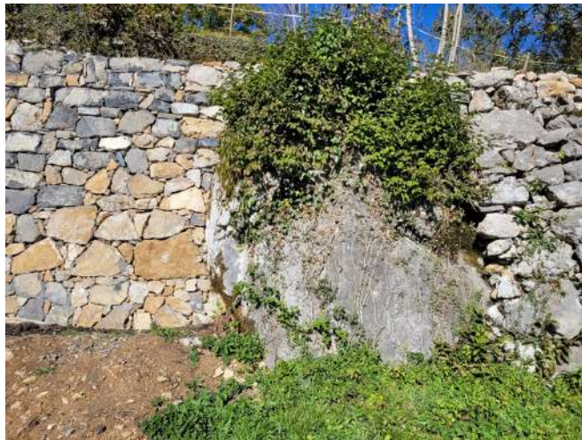
Fig. 7 - Muro di contenimento con leganti Val Brembana
