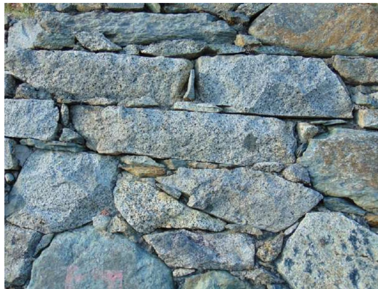
Figura 12 - particolare di manufatto con predominanti elementi granitoidi (granodiorite), in parte con un naturale assetto tabulare dovuto alla presenza di giunti subparalleli in affioramento, e subordinati altri litotipi (ben riconoscibile alcune serpentiniti), strada x Ligari, Triangia (SO). (immagine: Alfredo Dell'Agosto)
