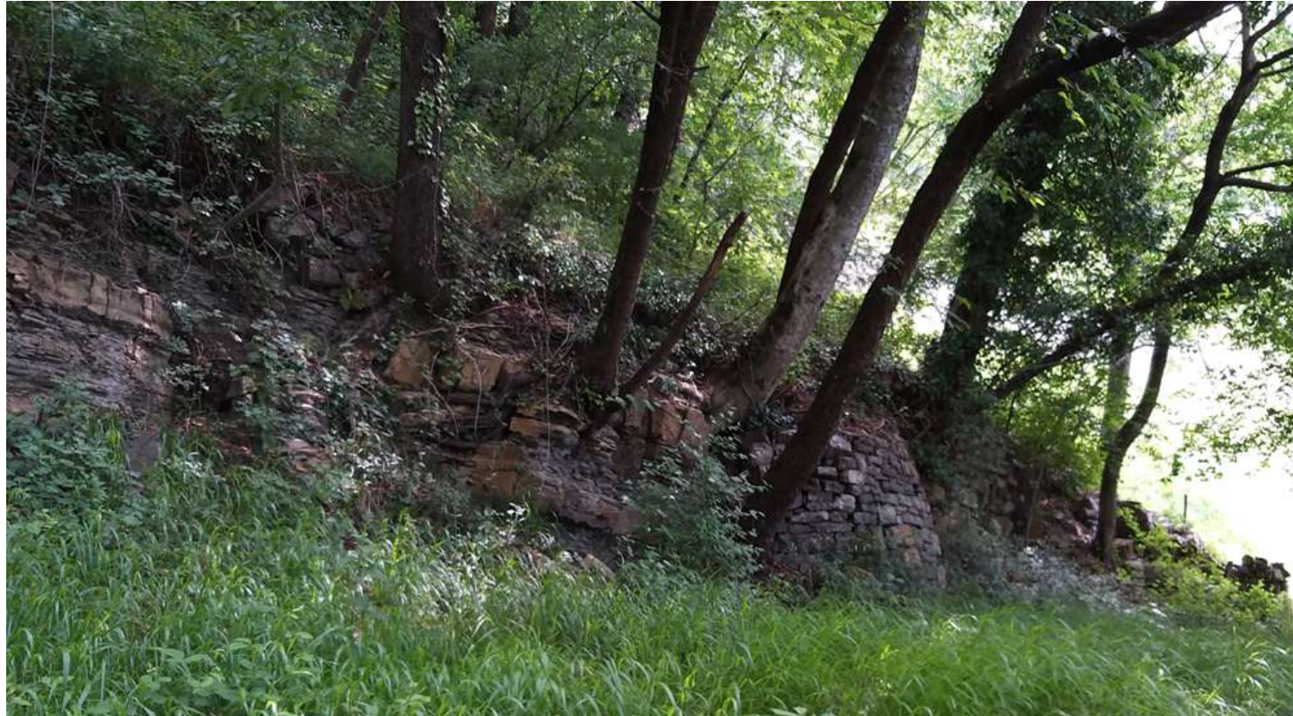
Figura 13 - Terrazzamento rimboschito in cui i muretti a secco si alternano alla roccia. Foto realizzata dalla scrivente in località Corna, Comune di Corna Imagna
