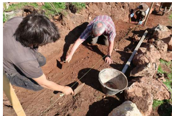
Fig. 19 - Preparazione del piano di fondazione, ovvero il piano di attesa della fondazione su terra. Si noti l'utilizzo della cazzuola e anche della bolla per verificare l'inclinazione del piano.
