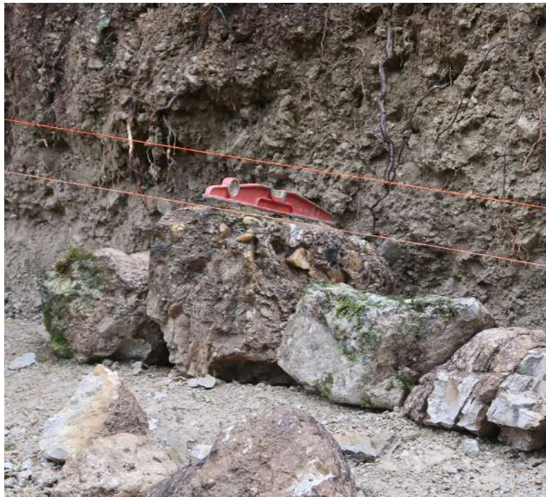
Fig. 36 - Verifica dell'inclinazione del piano di attesa di una pietra di fondazione per mezzo della bolla
