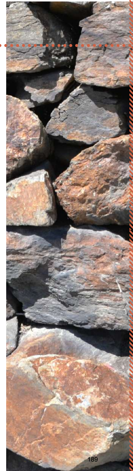
Figura 11 - muro con prevalenti elementi di rocce granitoidi del Terziario (granodiorite), affiorante in sito, e subordinati elementi alloctoni (serpentiniti, ortogneiss, . . .) – loc. Ligari, Triangia (SO). (immagine: Alfredo Dell'Agosto)
