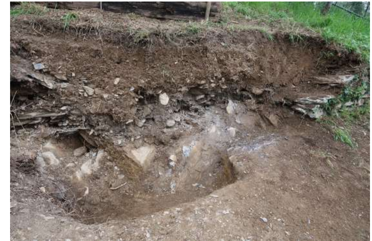
Fig. 21 - Preparazione di una fondazione in parte su roccia.
