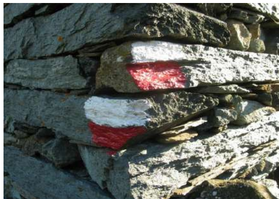
Figura 13 - particolare di manufatto con elementi angolari di serpentinoscisto, disposti in modalità alternata a formare gli elementi guida delle due facce di un angolo importante - Valmalenco. (immagine: Alfredo Dell'Agosto)
