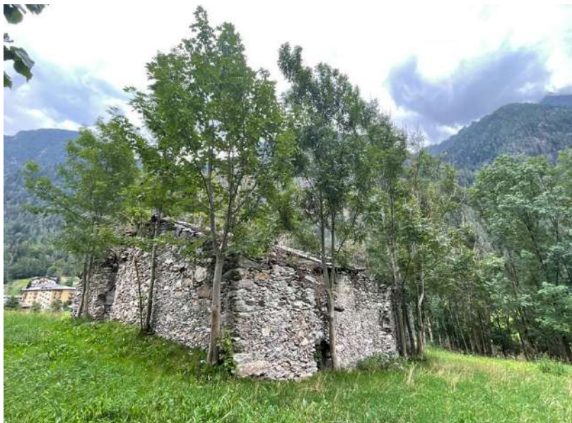
Figura 2 - Le rimanenze di un edificio rurale costruito con muri a secco oggi impreziosito dalla vegetazione che lo circonda. Branzi, Val Brembana (Foto Ilaria Mazzoleni)
