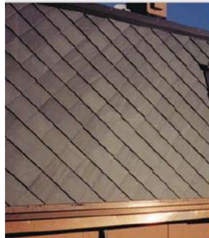
Figura 4 - Esempi di applicazione per realizzazione coperture (tipo Svizzero, Francese, Irregolare - immagini tratte dalla brochure CEA Società Cooperativa Escavatori Ardesie - Valleve Capo Brembo)
