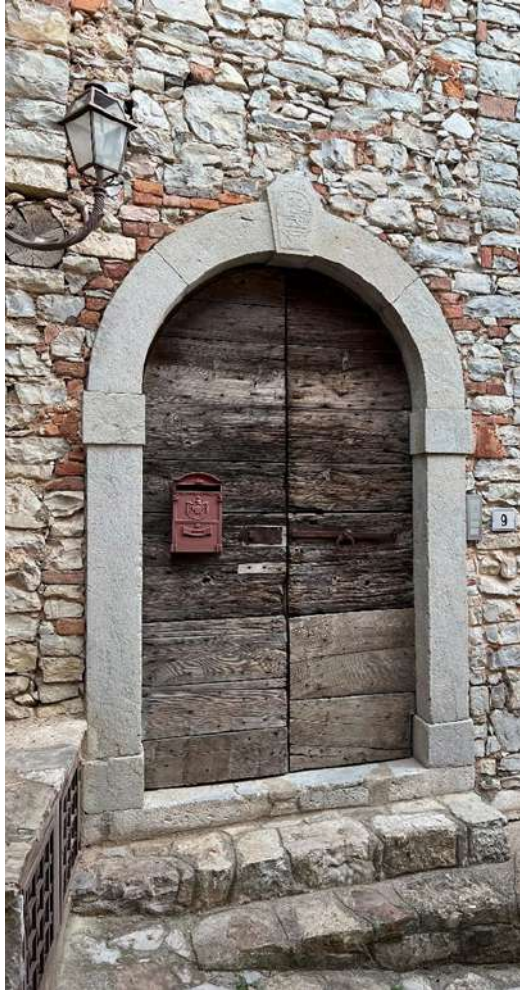
Figura 2 - foto di un portale in calcare Giurassico alla frazione di Opreno di Caprino Bergamasco (BG). Fabio Baio, Luglio 2022
