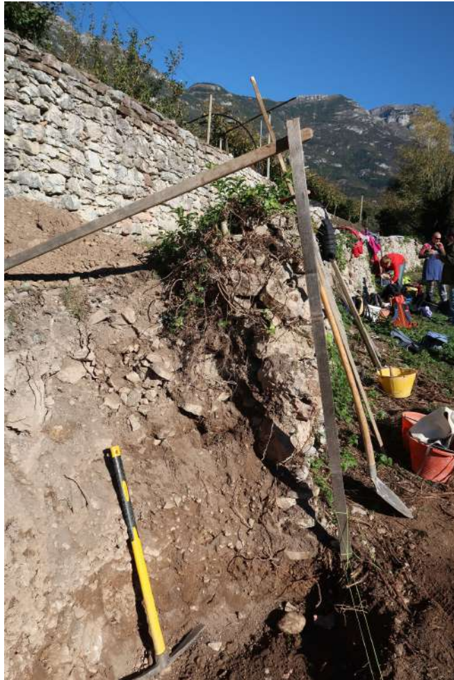
Fig. 27 A e B - Utilizzo dei montanti guida per costruire il profilo del muro a scarpa. Il caso A rappresenta la ricostruzione in continuità con un muro esistente che si usa come riferimento per l'inclinazione della scarpa. Il caso B è la costruzione di un nuovo muro con una scarpa progettata per il caso specifico.
