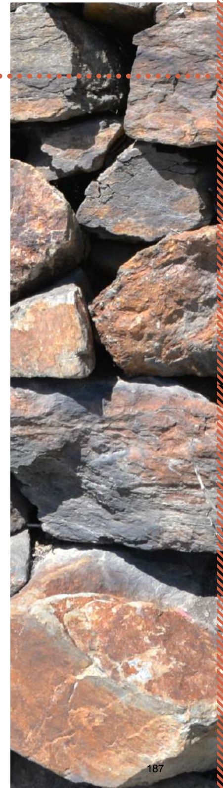
Figura 7 - muro con composizione eterogenea, con abbondanti componenti alloctoni, soprattutto litotipi granitoidi e metagranitoidi, ma anche serpentiniti, gneiss, quarziti, anfiboliti, in ambito di depositi glaciali – Castione Andevenno. (immagine: Alfredo Dell'Agosto)
