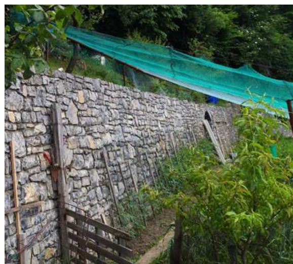
Figura 9 e 10 - Muro a secco (a sinistra) e bancata rocciosa (a destra). Foto realizzate dalla scrivente in località Corna, Comune di Corna Imagna
