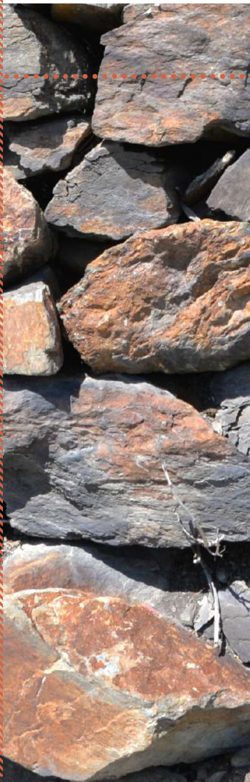
Fig. 37 – Formazione di corretti letti di posa
