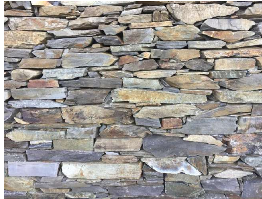
Figura 7 - Muro a secco a Camporeso di Galbiate, Fabio Baio; Figura 8 - Tessitura di muro con elementi tabulari, dovuta alla disponibilità di pietre metamorfiche scistose, Fabio Baio, Luglio 2022 Acquanera Valmalenco
