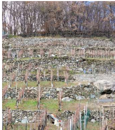
Fig. 6 - Muro di contenimento senza leganti Valtellina
