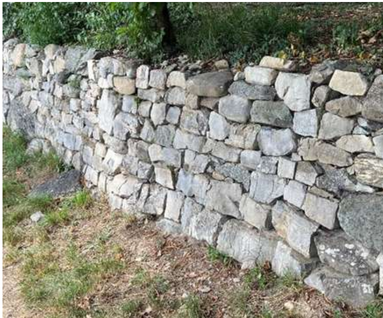
Figura 7 - Muro a secco a Camporeso di Galbiate, Fabio Baio; Figura 8 - Tessitura di muro con elementi tabulari, dovuta alla disponibilità di pietre metamorfiche scistose, Fabio Baio, Luglio 2022 Acquanera Valmalenco
