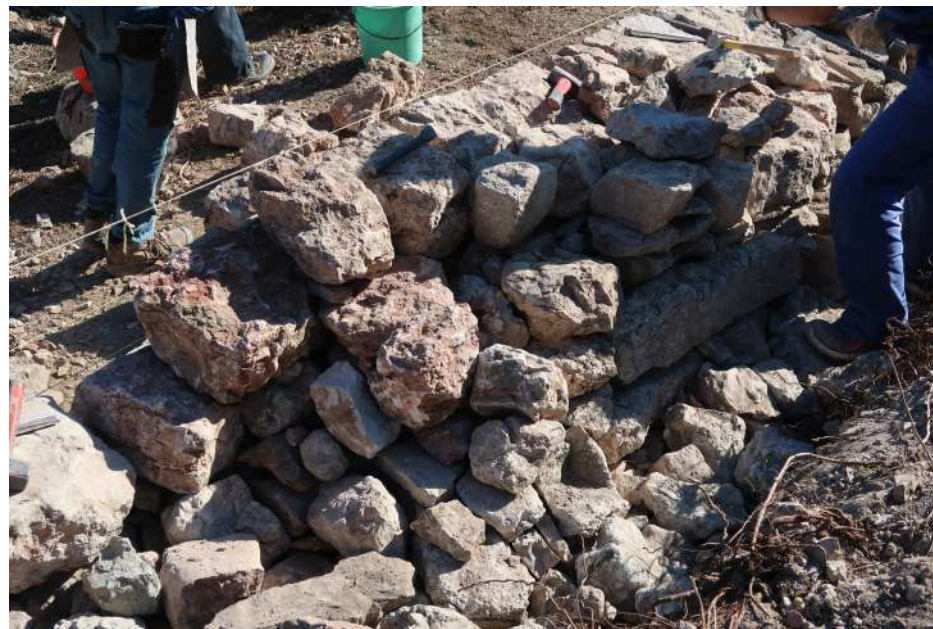
Fig. 48 A e B - Due esempi di drenaggio. Esempio A costituito da scagli di lavorazione e pietre molto piccole gettate sul retro per essere compattate. Esempio B costituito da pietre medio piccole poggiate a strati.
