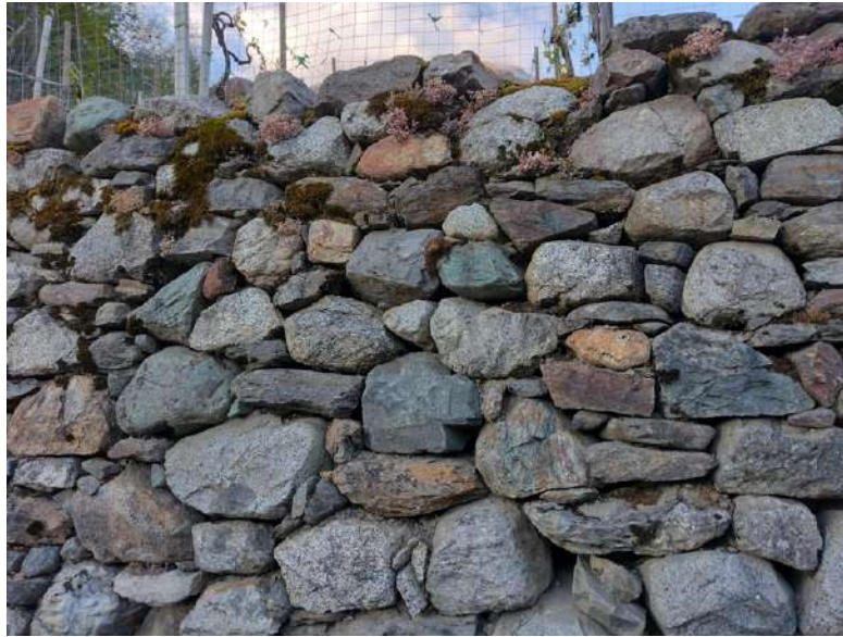
Figura 7 - muro con composizione eterogenea, con abbondanti componenti alloctoni, soprattutto litotipi granitoidi e metagranitoidi, ma anche serpentiniti, gneiss, quarziti, anfiboliti, in ambito di depositi glaciali – Castione Andevenno. (immagine: Alfredo Dell'Agosto)
