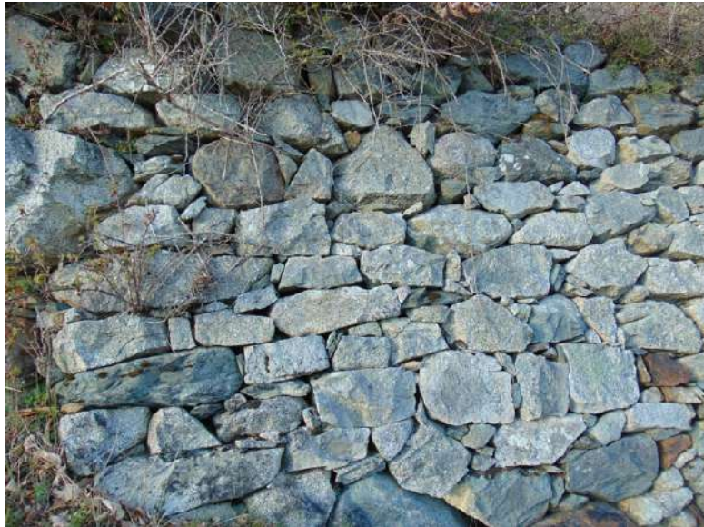
Figura 11 - muro con prevalenti elementi di rocce granitoidi del Terziario (granodiorite), affiorante in sito, e subordinati elementi alloctoni (serpentiniti, ortogneiss, . . .) – loc. Ligari, Triangia (SO). (immagine: Alfredo Dell'Agosto)
