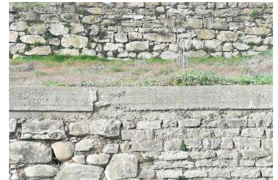
Fig. 22 - Interventi con cemento Valtellina
