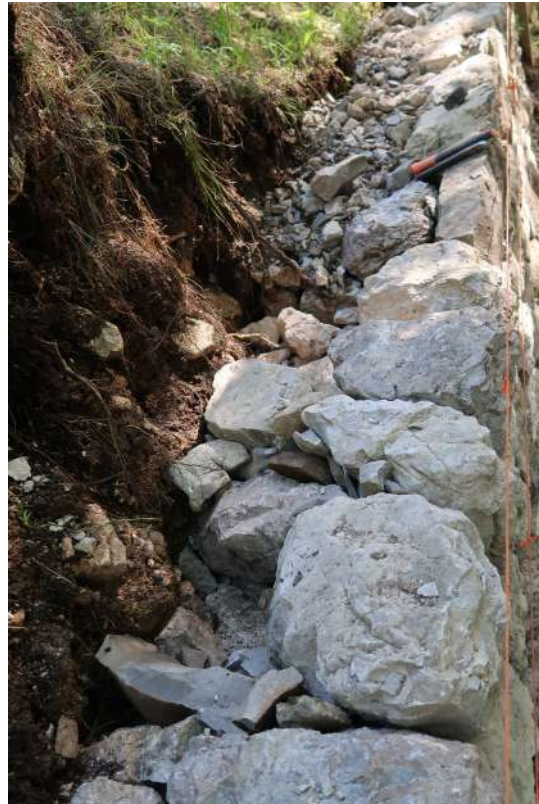
Fig. 48 A e B - Due esempi di drenaggio. Esempio A costituito da scagli di lavorazione e pietre molto piccole gettate sul retro per essere compattate. Esempio B costituito da pietre medio piccole poggiate a strati.
